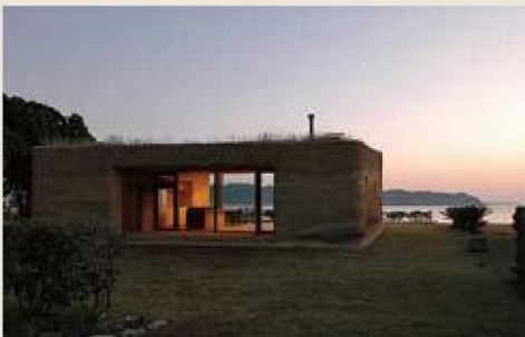
House C 地層の家
