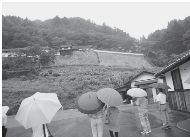
雨中の広兼邸の石積み擁壁
