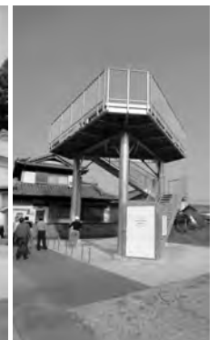
津波避難タワー
